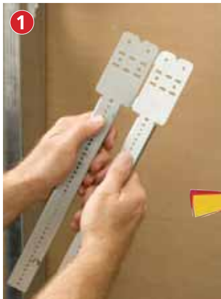
1. Zegnij wspornik TSGB w miejscu nacięcia.
