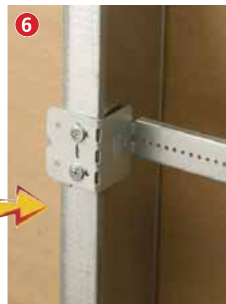
6. Zamontuj wspornik TSGB na słupkach za pomocą płaskich wkrętów, nr artykułu 187197.
